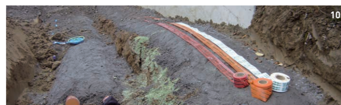
10 Werkleitungen mit Warnbändern
